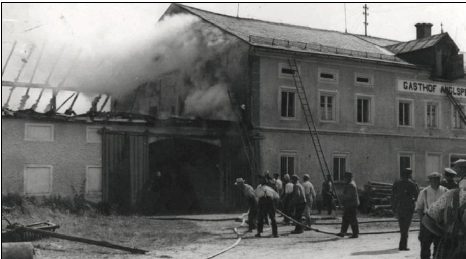
Brand 1968 des Gasthauses Anglsperger-Brechtken.
