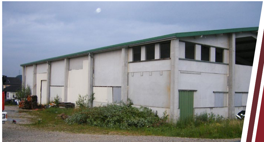
Das aktuelle Feuerwehrhaus, noch in seinem Ur-Zustand.
